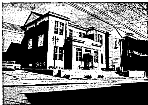
郡上八幡博覧館 全景
